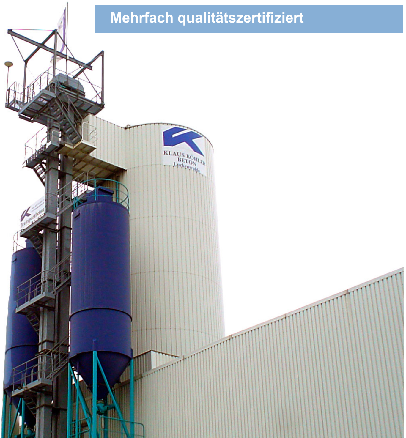
KÖHLER BETON Fertigteilwerk in Luckenwalde
